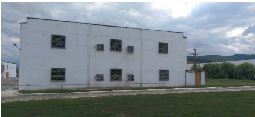
Figura 5.2 Poziționarea ventilatoarelor la capătul longitudinal al halei Figure 5.2 Location of fans at the longitudinal end of the shelter
