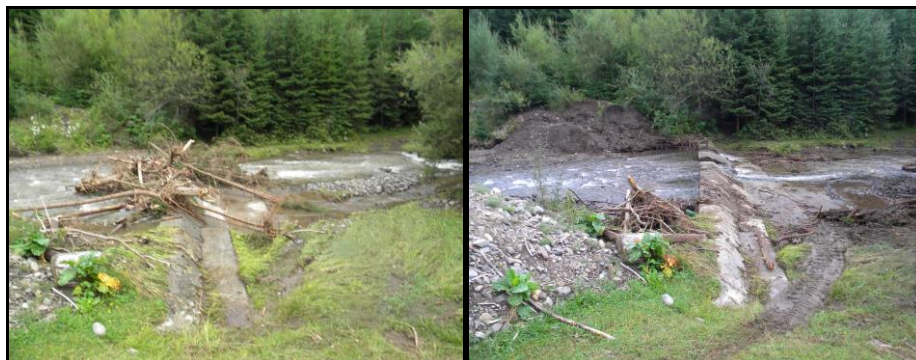
Figura 6.9 Captarea Dornișoara colmatată cu resturi lemnoase provenite de la exploatarea forestieră aflate în amonte de CHEMP (original) Figure 6.9 Intake Dornișoara clogged with wood remnants from forest exploitations upstream of SHP (original)
