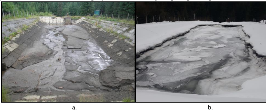
Figura 5.14 Bazinului compensator a CHEMP Vorova (a) pregătire pentru decolmatare (b) vedere asupra bazinului iarna (original)
