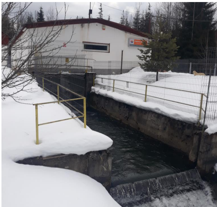
Figura 5.5 Clădirea CHEMP Dornișoara (original)
