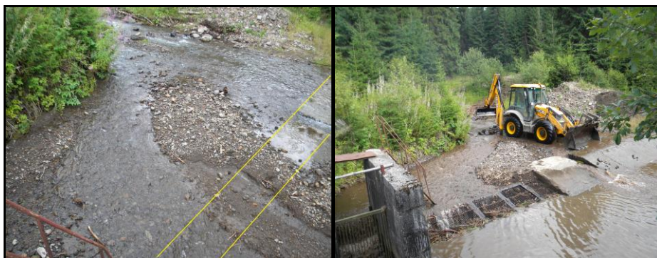
Figura 6.8 Lucrare de decolmatare a captării Dârmoxa (original) Figure 6.8 Unsilting intake of Dârmoxa SHP (original)
