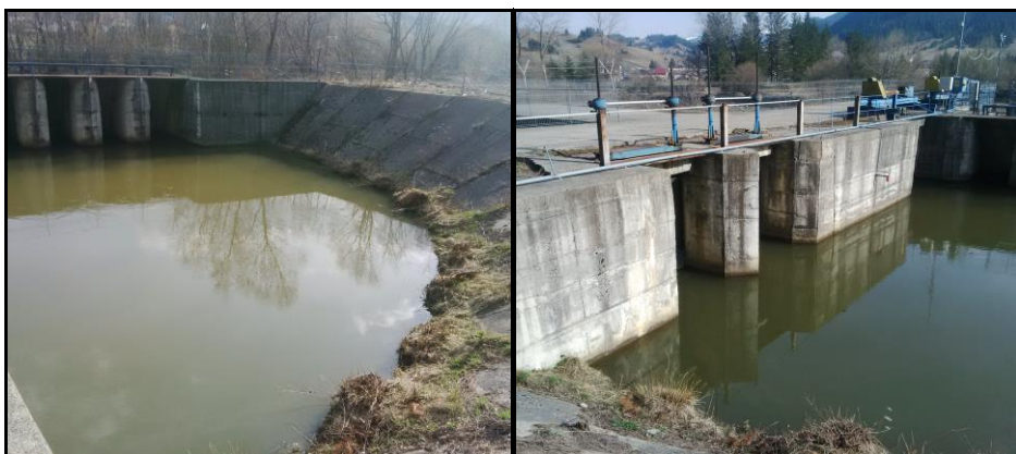
Figura 5.16. Bazinul deznisipator CHEMP Pojorâta (original)
