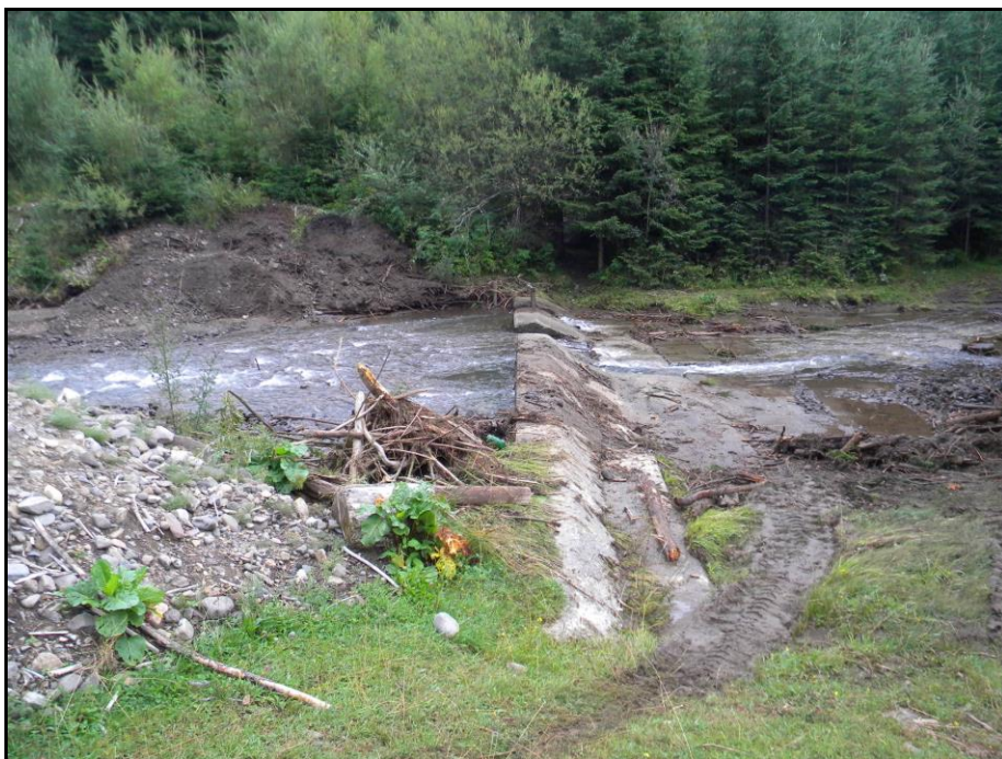
Figura 5.2. Captarea secundară a CHEMP Dornișoara amenajată pe pârâu Vorova (original) Figure 5.2. Secondary intake of SHP Dornisoara fitting on Vorova river (original)
