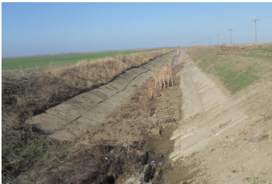
Figura 5.10 Canalul de aducțiune CA8 înainte de reamenajare Figure 5.10 CA8 supply channel before refurbishment
