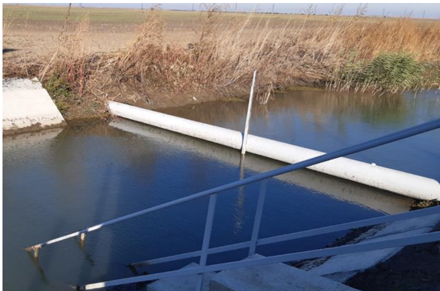
Figura 4.6 Supratraversarea conductei spre antenă
