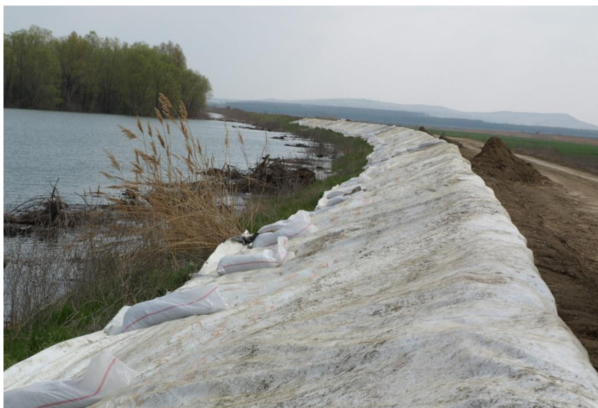
Figura 4.1 Lucrări pentru supraînălțarea digului din IMB
