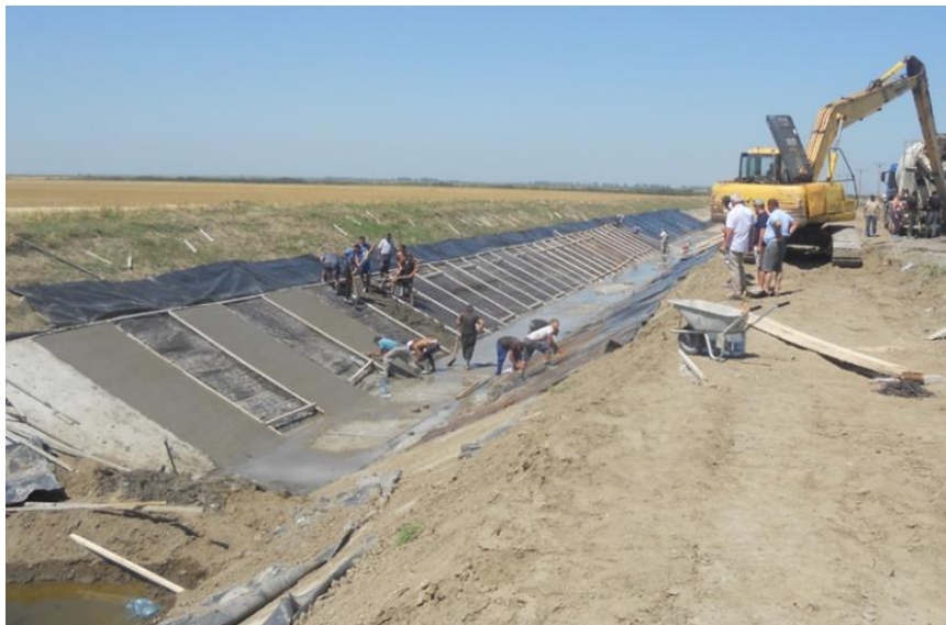
Figura 5.12 Turnarea placilor din beton Figure 5.12 Pouring concrete slabs
