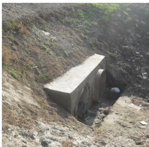
Figura 5.14 Reabilitare podețe Figure 5.14 Bridge rehabilitation
