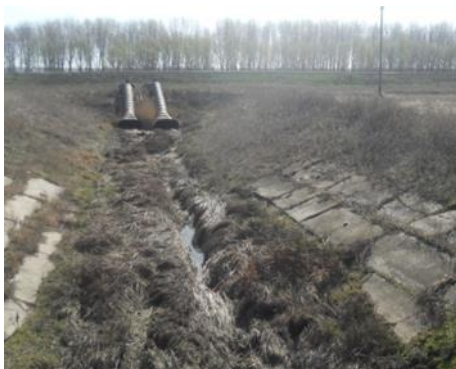
Figura 5.15 Decolmatarea canalelor de depuneri și vegetație Figure 5.15 Clogging of deposition and vegetation channels
