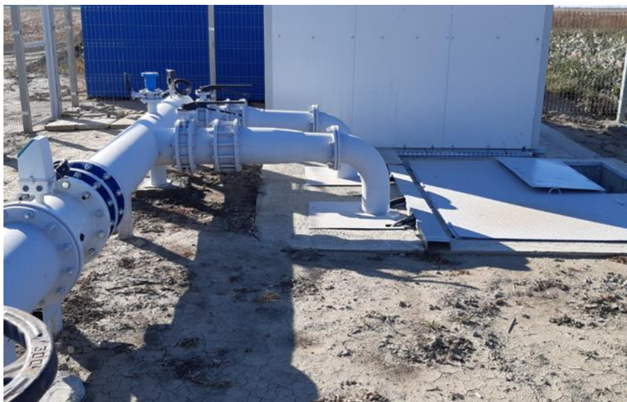
Figura 4.4 Realizarea construcțiilor anexe pentru stații de tip cava din beton Figure 4.4 Realization of the annex constructions for concrete tank type stations
