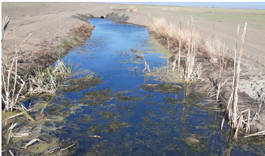
Figura 5.5 Canal terțiar de desecare Figure 5.5 Tertiary drainage channel
