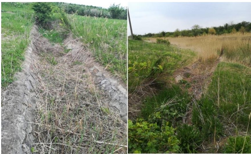
Figura 6.22 Debușeu din beton, înființat în livadă, pentru controlul scurgerii apei, Deleni (original)
