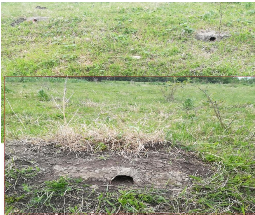
Figura 6.21 Guri de evacuare la drenuri absorbante, pentru captarea izvoarelor de coastă, Maxut (original)
