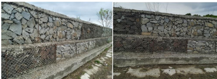
Figura 6.14 Zid de sprijin confecționat din gabioane umplute cu piatră, Cotnari (original)
