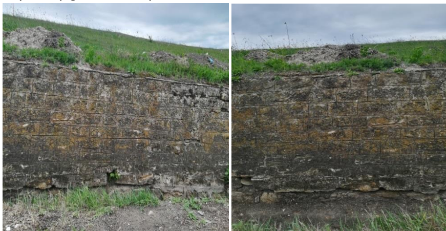
Figura 6.18 Zid de sprijin împotriva alunecărilor de teren pe pășune, Poiana Deleni (original)
