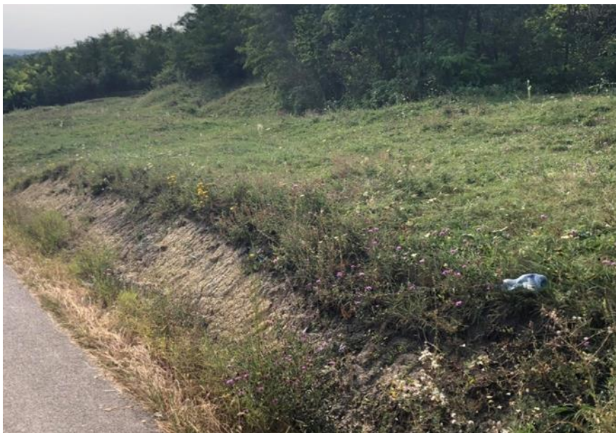
Figura 5. 13. Prăbușiri datorate excesului de umiditate, Fântânele(original) Figure 5. 13. Collapses due to excess moisture, Fantanele
