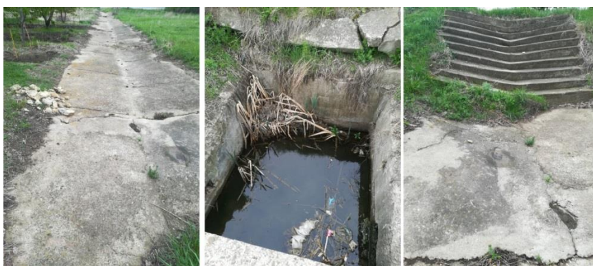
Figura 6.25 Lucrări speciale pentru dirijarea scurgerii de suprafață pe un versant cu livadă și viță-de-vie, Cotnari (original) Figure 6.25 Special works for directing surface drainage on a slope with orchard and vineyards, Cotnari (original)
