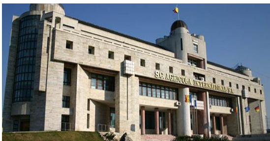
Fig. 5.2. Sediul Companiei Agricola International S.A. Bacău (foto original)
