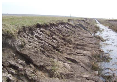
Figura 4.24 - Eroziunea taluzurilor și colmatarea fundului canalului (original)
