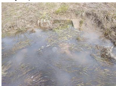
Figura 4.25 - Guri de evacuare colmatate (original)
