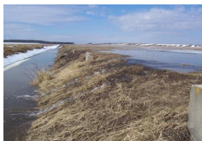
Figura 4.23 - Preluarea apei revărsate de canalul colector Șomuzel (original)
