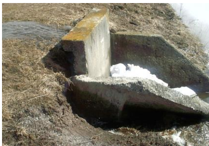
Figura 4.23 - Preluarea apei revărsate de canalul colector Șomuzel (original)
