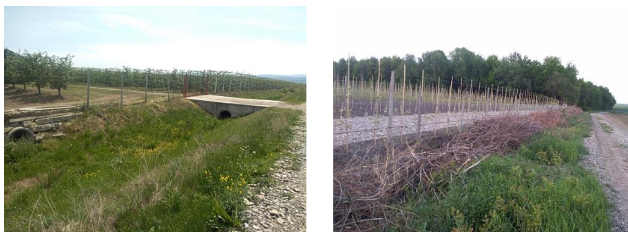
Figura 5.27 - Canal de desecare cu vegetația lemnoasă defrișată și podeț construit de către proprietarul livezii (original)
