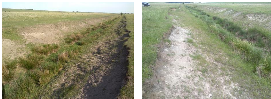
Figura 4.13 - Eroziune de mal (original)
