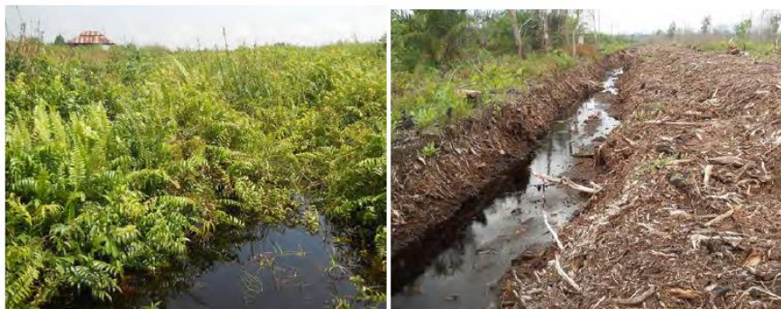
Figura 1.8 - Canal de desecare înainte și după dragare (Dollinger, 2017)
