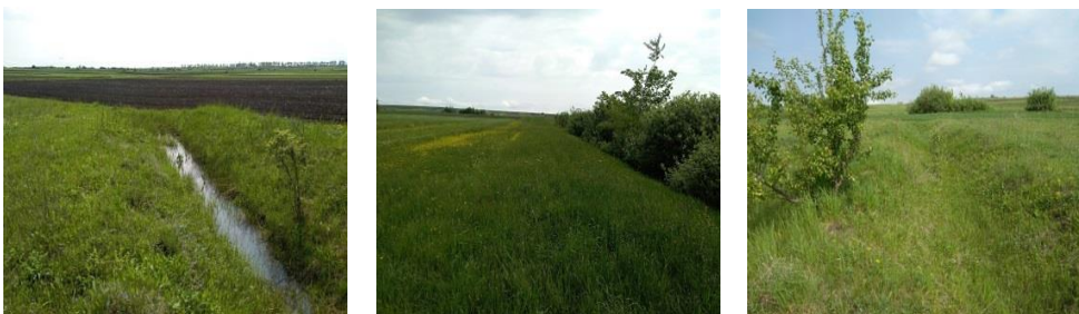
Figura 5.14 - Starea actuală a canalelor (original)
