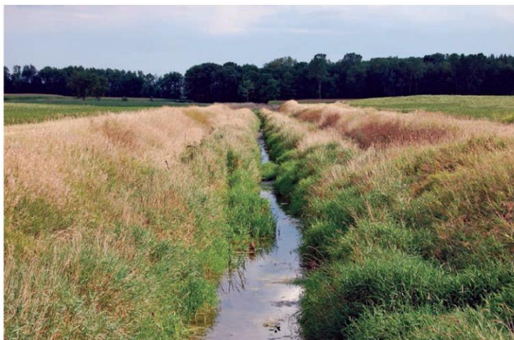
Figura 1.6 - Canal construit în două trepte, în Hillsdale County, Michigan, fără aplicarea lucrărilor de întreținere timp de șase ani (Kalcic, 2018)
