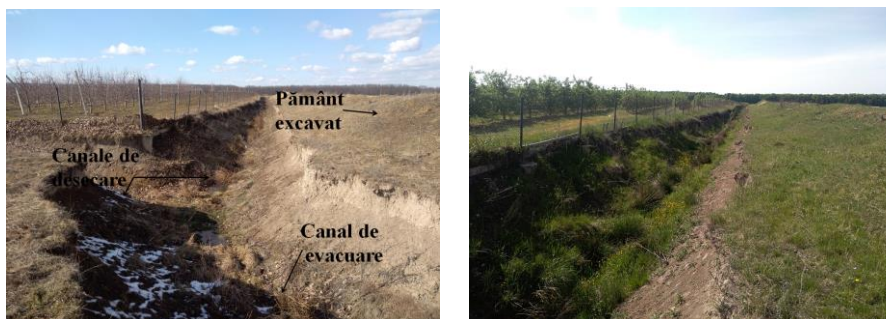
Figura 4.28 - Canale executate, în regim privat, pentru eliminarea excesului de apă din plantația de măr (original)
