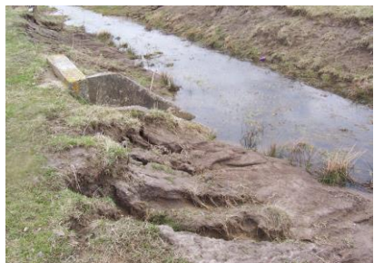
Figura 4.24 - Eroziunea taluzurilor și colmatarea fundului canalului (original)
