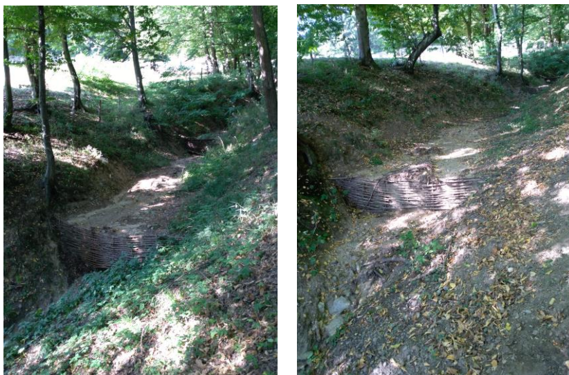
Figurile 7.16 și 7.17 Cleionaje executate în amenajarea Șerbăuți-Calafindești (original) Figures 7.16 and 7.17 Spurs executed in Șerbauti-Calafindești facility (original)
