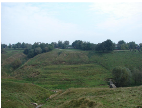
Figurile 7.19 și 7.20 Praguri care și-au epuizat capacitatea de retenție (original) Figures 7.19 and 7.20 Thresholds that have exhausted their retention capacity (original)
