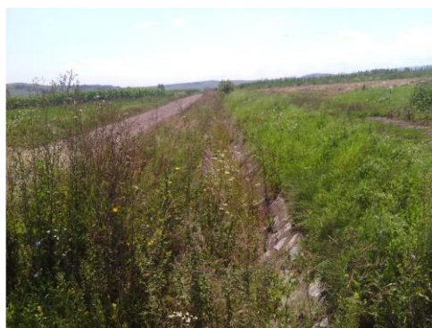
Figurile 7.4 și 7.5 Canale marginale de coastă invadate de vegetație, amenajarea C.E.S. Dornești Frătăuții Noi-Siret (original)
