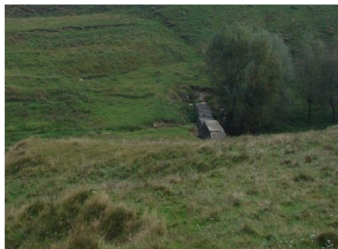
Figurile 7.19 și 7.20 Praguri care și-au epuizat capacitatea de retenție (original) Figures 7.19 and 7.20 Thresholds that have exhausted their retention capacity (original)
