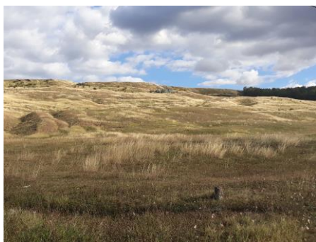
Figura 5.10 Pășune afectată de eroziune de suprafață și eroziune în adâncime, Preutești (original)
