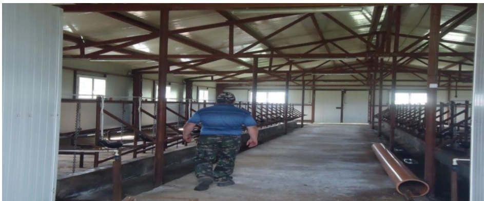
Figura 4.9. Adăpost pentru taurine din ferma L5-vedere din interior (foto original) Figure 4.9 Shelter for cattle on farm L5- view from inside (original foto)
