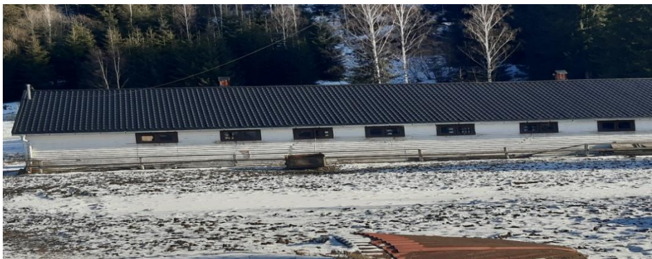
Figura 4.7. Adăpost pentru taurine din ferma L3 -vedere din exterior (foto original)
