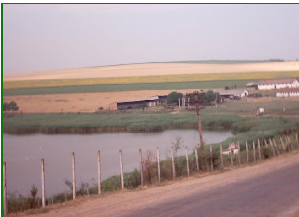
Fig. 7.1. Lucrări pentru combaterea eroziunii solului pe terenurile cu panta de 12%
