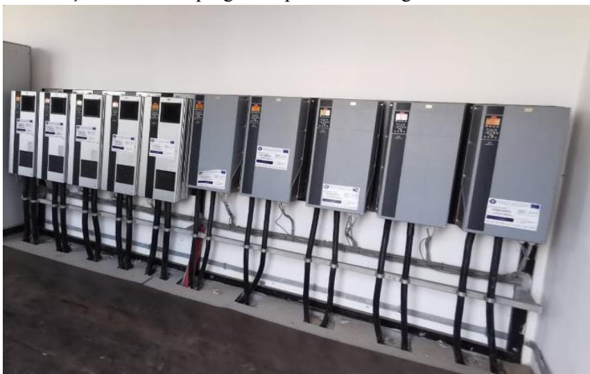
Figura 5.16. Măsurarea parametrilor electrici Figure 5.16. Measurement of electrical parameters
