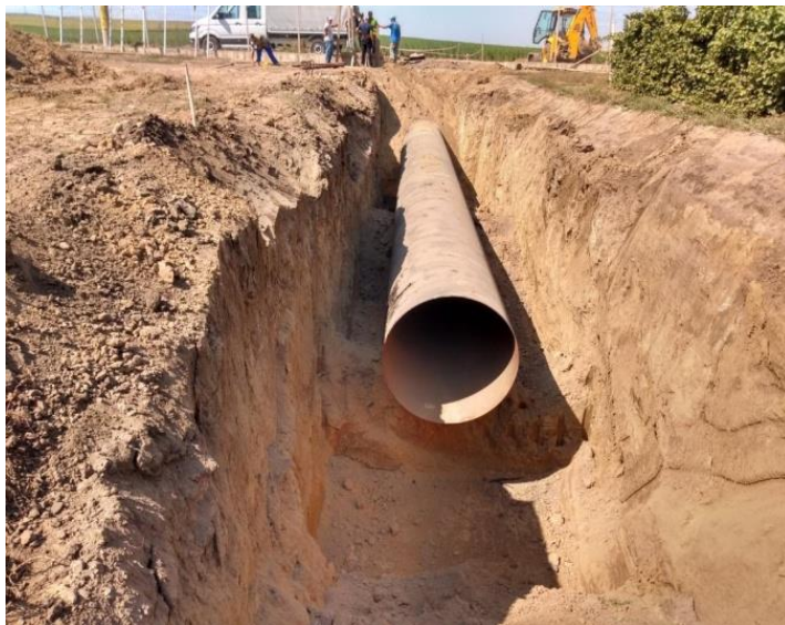
Figura 5.15. Montarea conductelor în pământ Figure 5.15. Installation of pipeline in the ground
