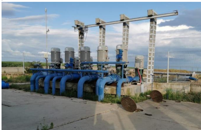
Figura 5.3. Electropompele și conducta CP2b, după reabilitare
