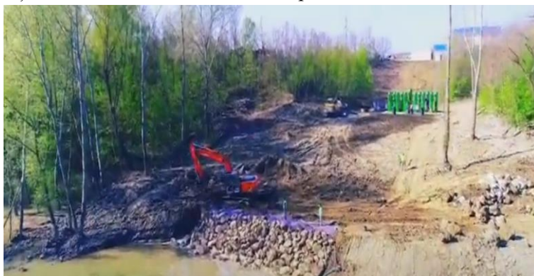
Figura 5.13. Lucrări de terasamente Figure 5.13. Earthworks
