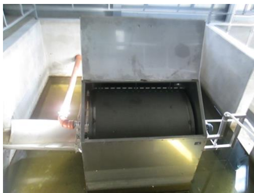
Figura 9.6 Filtru cu tambur(foto original)
