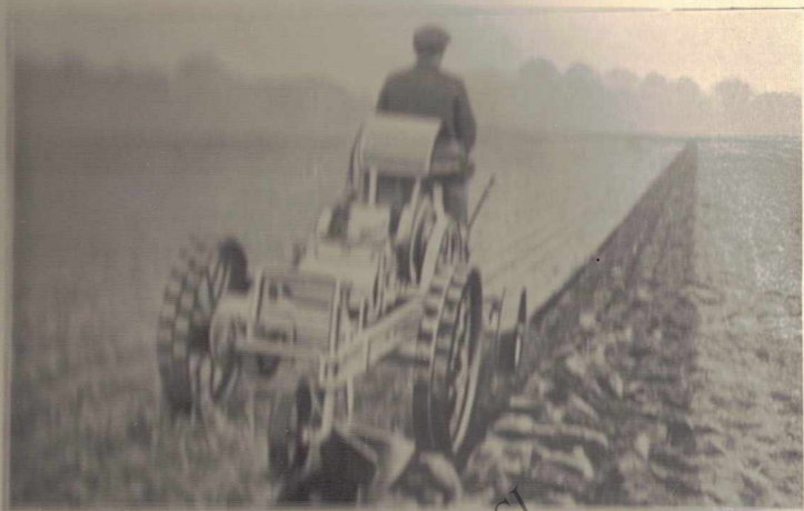
LE SOU ET LE SOU Le sou qui est tiré par des animaux ou un tracteur, produit des mottes, déchirer la terre, l'ameublir.
