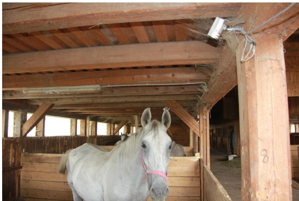
Figura 3.16. Utilizarea sistemelor de supraveghere video (original)
